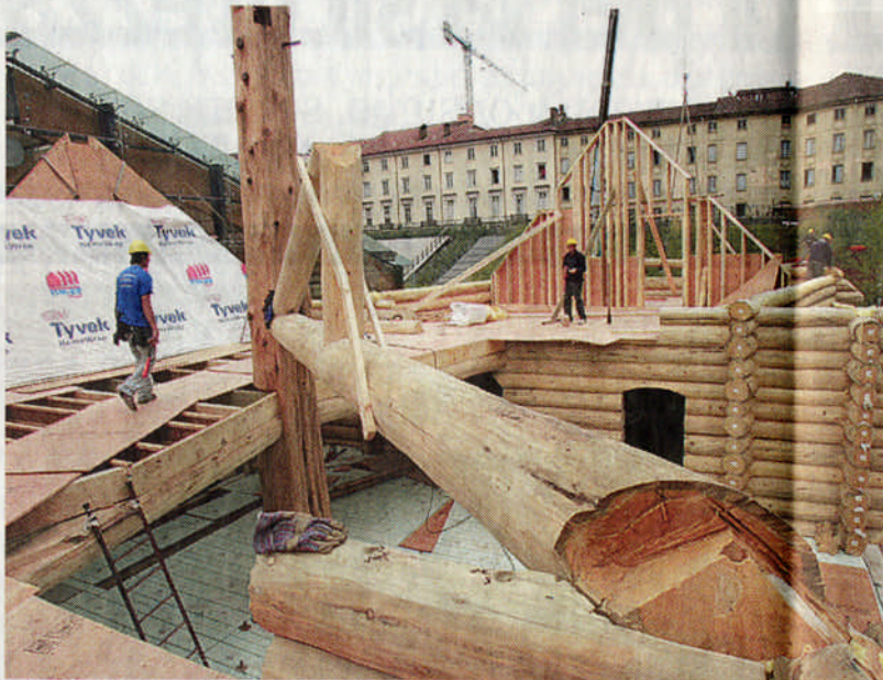
Lo chalet canadese in costruzione in piazza Valdo Fusi
